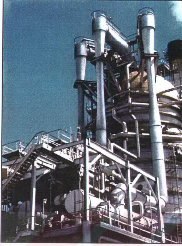
Şekil 4.7 Vakum distilasyon kulesi.
