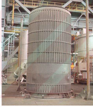
Şekil 3.7 Rulo üstündeki gömlek içine nötr gaz verilmesi
