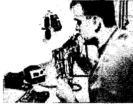
Şekil 2.15 Mum modellerin havya ile eritilerek yine mum malzemedan yapılmış model ağacına bağlanması[1]
