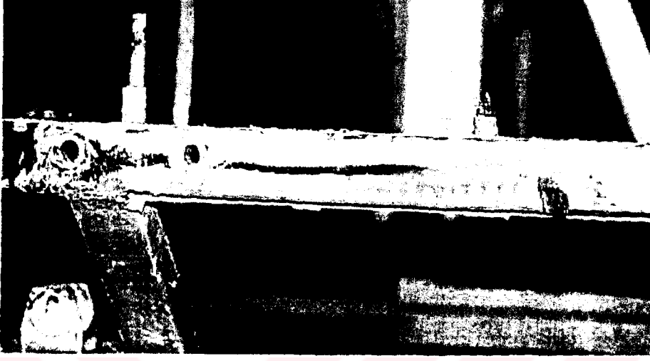
Şekil 5.30 Çinko ve thermovator bantlı sağ arka sütun
