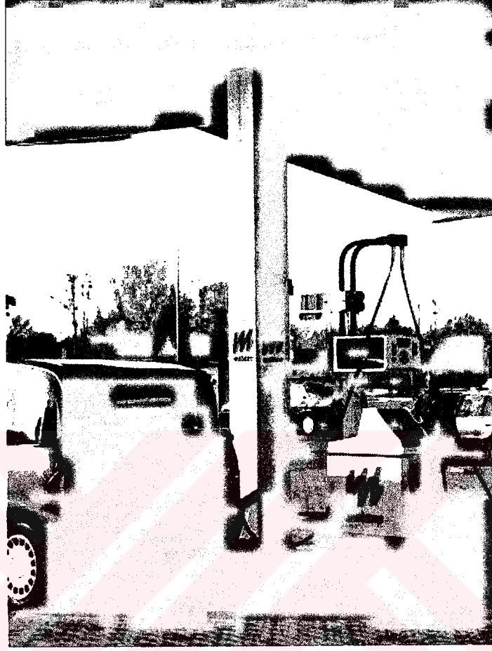
Şekil 5.2 Hızlı dolum ünitesi dispenseri (8 th ENGVA conference proceedings ,2002).
