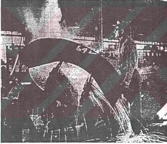
Şekil 11.21 Motorlu tip bir pozisyonlayıcı dönel fikstür (Arc welding engineering and production, 1944)
