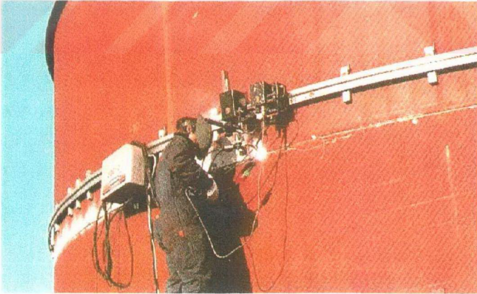
Şekil 11.65 Bir sıvı tankını kaynak etmek için kullanılan fikstür (Fiksan A.Ş. arşivi, 2000)
