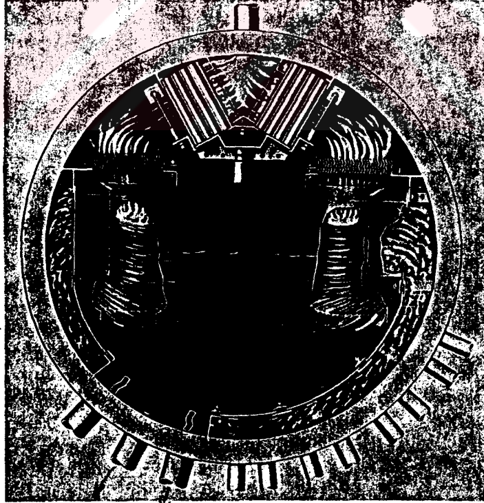
Şekil 2.2 Üst domda yer alan buhar siklonları (Babcock & Wilcox, 1972)
