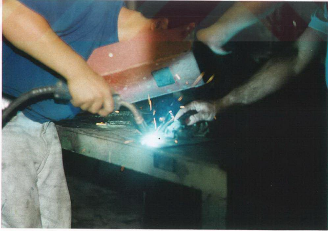
Şekil 5.6. Sabit Su Soğutmalı (Islak Bez Yardımı ile) MAG Kaynağı (MBS)
