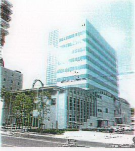
Yeni Medya Plaza Binası
