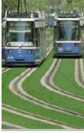
Şekil 2.12 Rasengleis monolitik rijit üstyapı sistemi (Yalçın, 2006).
