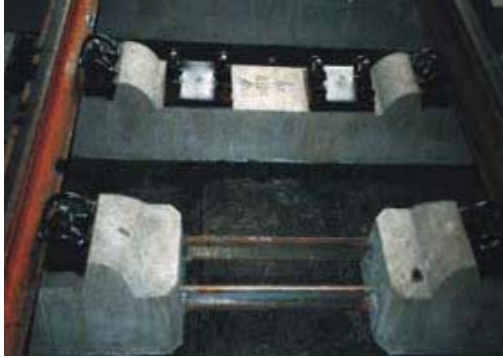
Şekil 2.11 ATD sistemi, Nant 1993 TT üzerine döşeli travers mesnetli rijit üstyapı sistemi (Yalçın, 2006).
