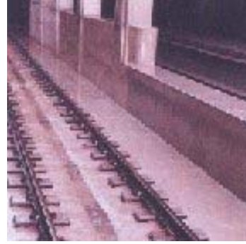
Şekil 2.10 LVT, TT içine gömülü travers mesnetli rijit üstyapı sistemi (Yalçın, 2006).
