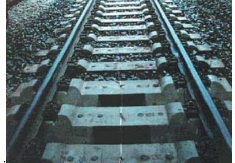
Şekil 2.13 GETRAC TT üzerine döşeli travers mesnetli rijit üstyapı sistemi (Yalçın, 2006).
