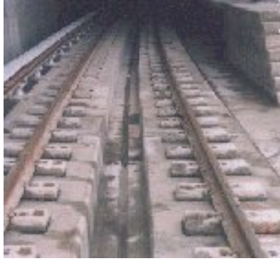
Şekil 2.10 LVT, TT içine gömülü travers mesnetli rijit üstyapı sistemi (Yalçın, 2006).
