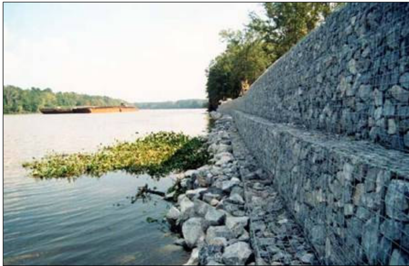
Şekil 2.11 Gabion tipi bir kıyı duvarı [9]
