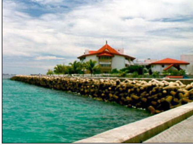
Şekil 2.6 Beton bloklu kıyı duvarı [4]
