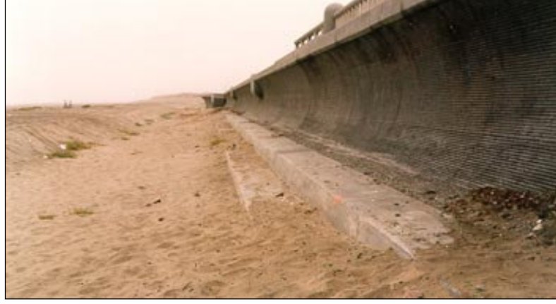
Şekil 2.10 Kavisli-yüzlü düşey kıyı duvarı [7]
