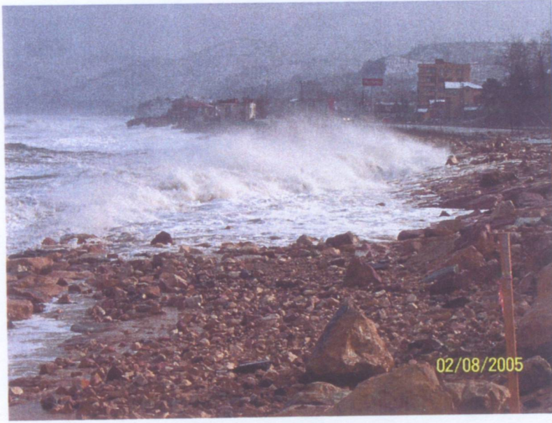
Şekil 6.22 Bolaman'daki hasarlı kesit fotoğrafı 1.
