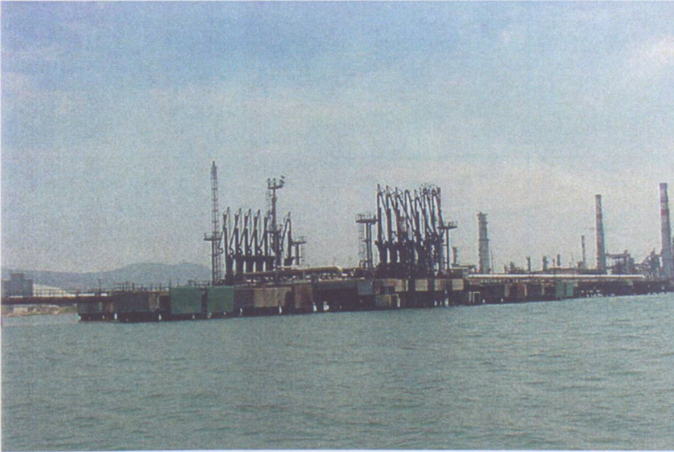
Şekil 6.13 Tüpraş Faz II İskelesi (2003).
