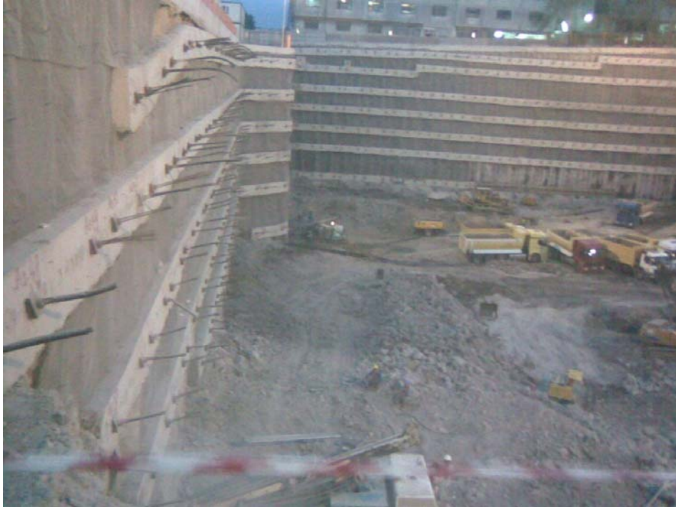
Şekil 10.2 İksa çalışmasından bir görünüş
