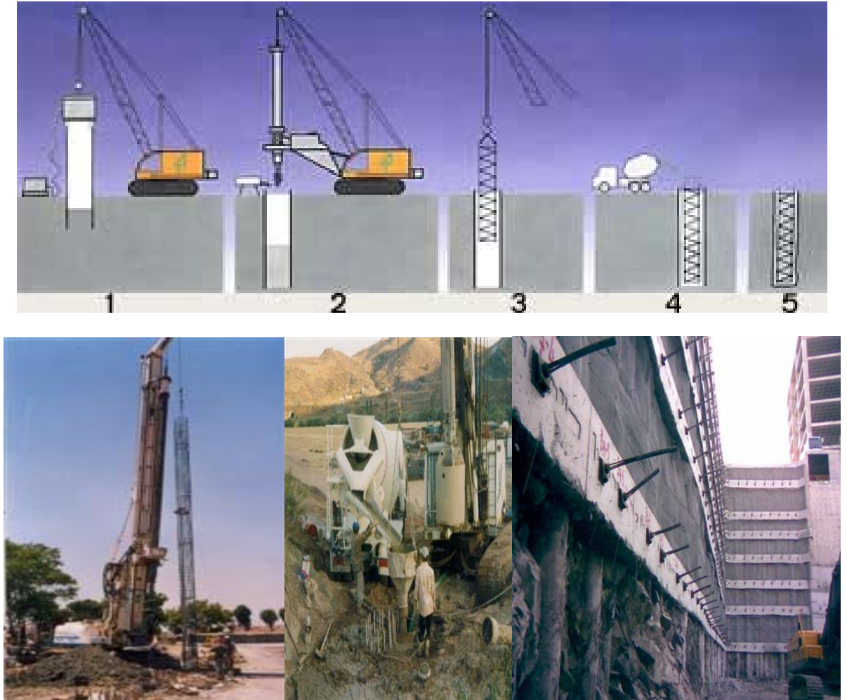
Şekil 2.9 Forekazık imalat safhaları ve ankraj destekli forekazık perde duvarı (www.temeltas.com.tr)
