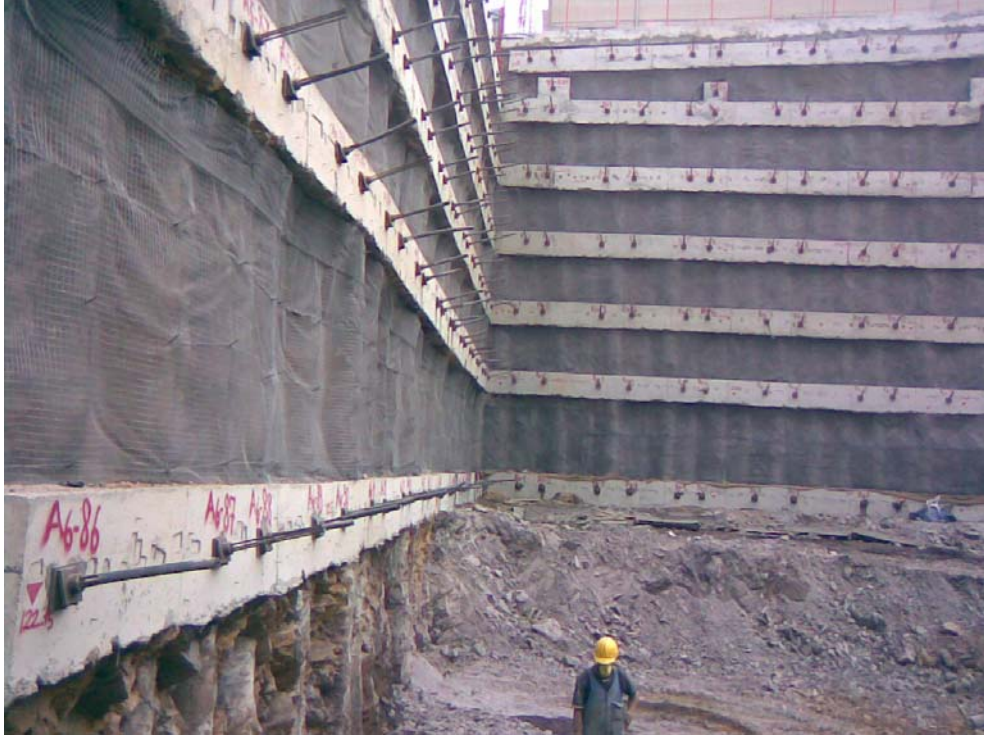
Şekil 10.3 Kademeler arası çelik hasır ile kaplama
