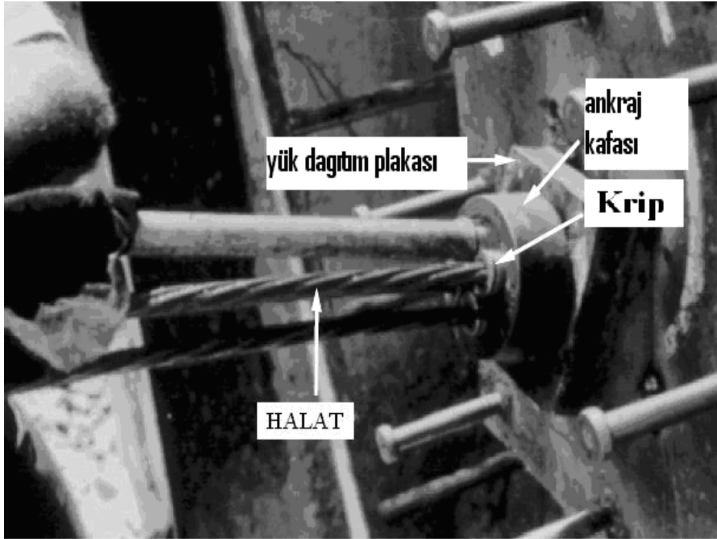
Şekil 6.4 Halat tendon için ankraj kafası bileşenleri
