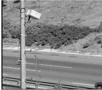
Şekil 6.5 Yol kenarına yerleştirilmiş bir RTMS
