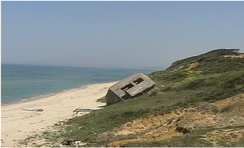
Şekil 4.3 Terkos kıyısı şeridindeki erozyonun yol açtığı hasarlar
