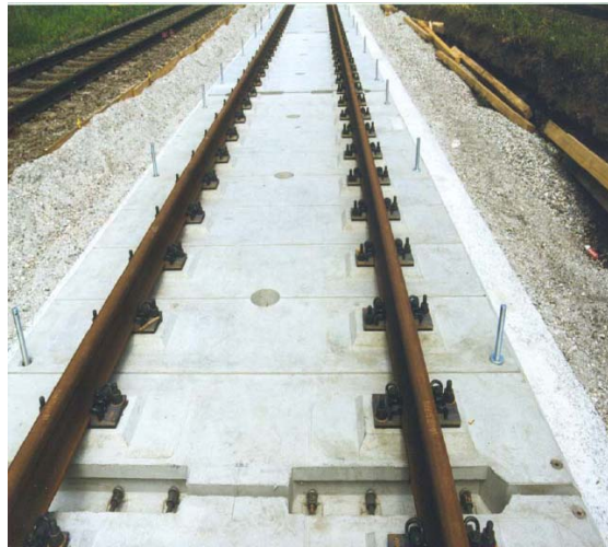
Şekil 2.21 Prefabrik balastsız üstyapı sistemi (Esveld, 2001).
