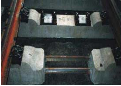
Şekil 2.19 Taşıma tabakası üzerine döşeli travers mesnetli rijit üstyapı sistemi (Erkul, 2003).
