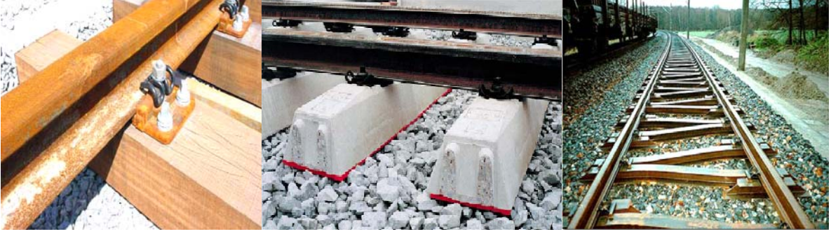
Şekil 2.5 Ahşap travers, betonarme travers ve çelik travers (Esveld, 2003).
