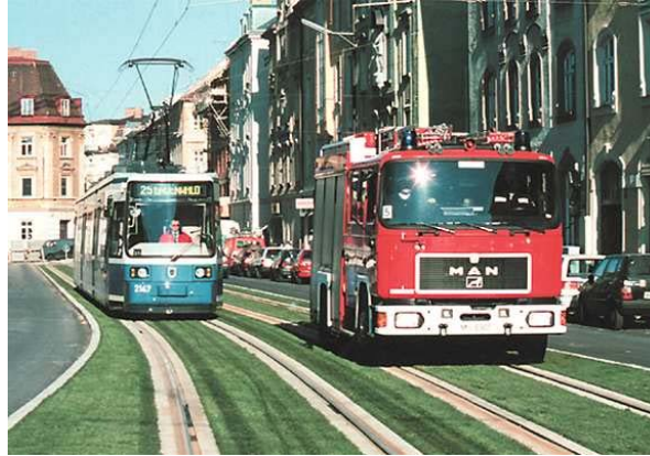
Şekil 2.25 Edilon Corkelast gömülü raylı yol sistemi (Esveld, 2001).
