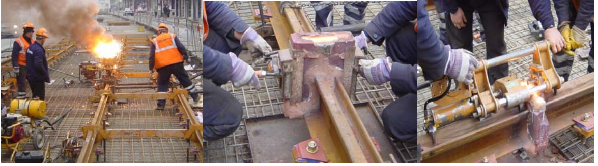
Şekil 2.13 Alüminotermit kaynak uygulaması.
