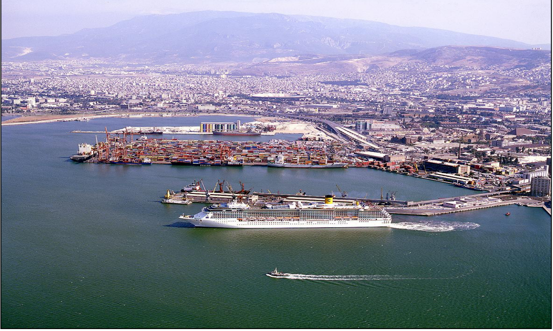
Şekil 6.2 İzmir Alsancak limanına ait genel görünüm (TCDD İzmir Liman İşletmesi Müdürlüğü, 2007)
