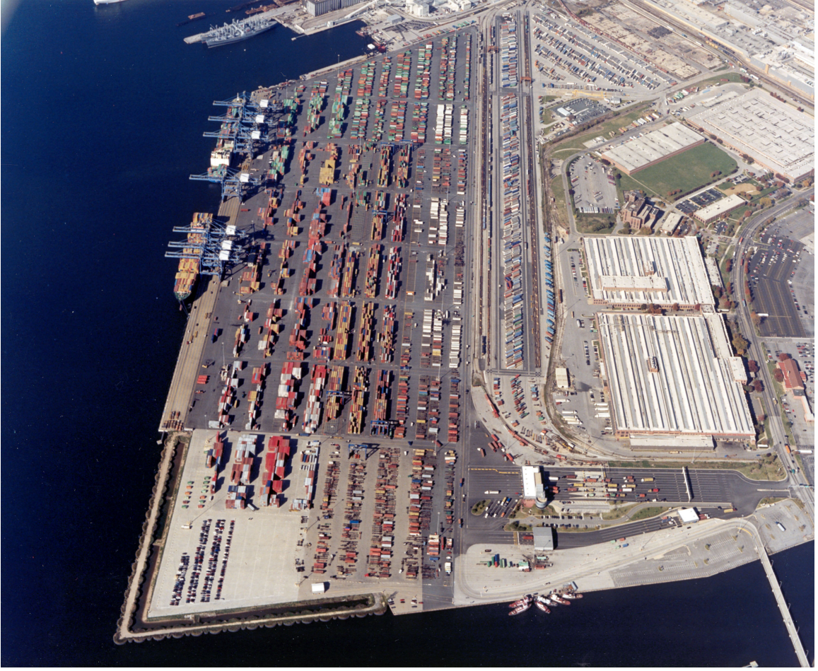
Şekil 4.11 Seagirt Marine Terminali'nde açık depo alanı
