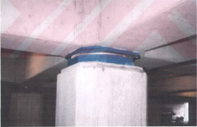
Şekil 2.14 Sürtünmeli sarkaç izolatör uygulaması
