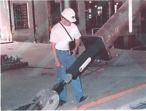
Şekil 3.16 Viskoelastik söndürücülerin çatı seviyesinde kullanımı
