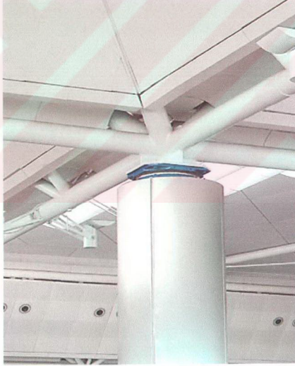
Şekil 2.18 Atatürk Havalimanı'nda kullanılan sürtülmeli sarkaç izolatörü
