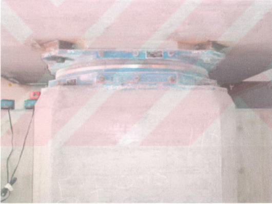
Şekil 2.16 Abovenet İletişim binasında kullanılan sürtünmeli sarkaç izolatörü
