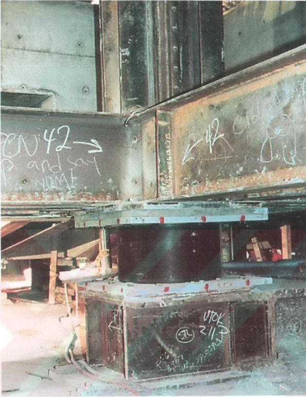
Şekil 2.11 Kurşun saplamalı silindirik kauçuk izolatör
