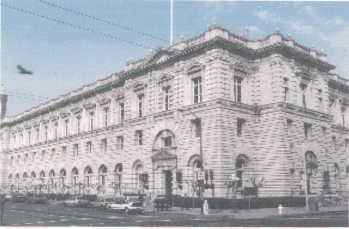
Şekil 2.13 Birleşik Devletler Yargıtay binası
