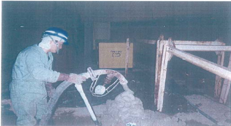
Şekil 3.4 Beton hortumundan püskürtülen yüksek sıklıkta koyu beton malzemesi (Arslan, 2006).
