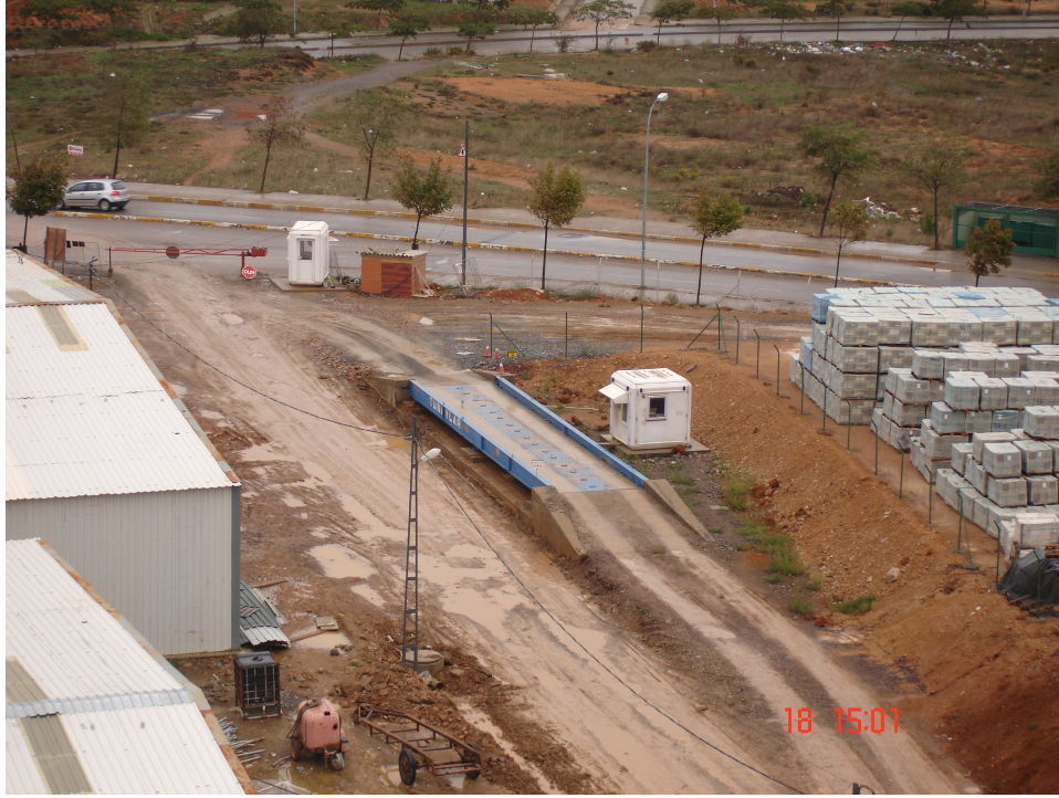
Şekil 3.11 Şantiye girişi ve güvenlik noktası ile kantar
