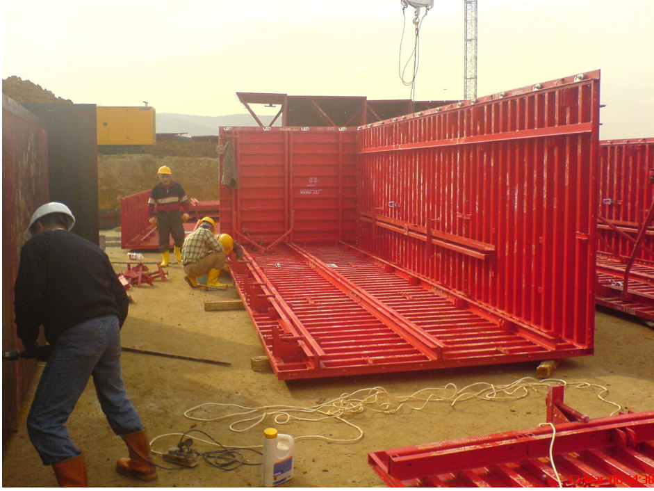
Şekil 3.18 Tünel kalıp kurumu
