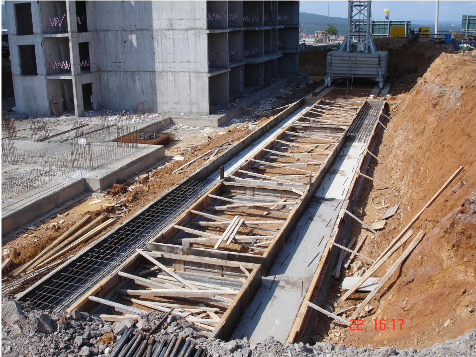
Şekil 3.15 Vinç temeli ve yolu imalatı
