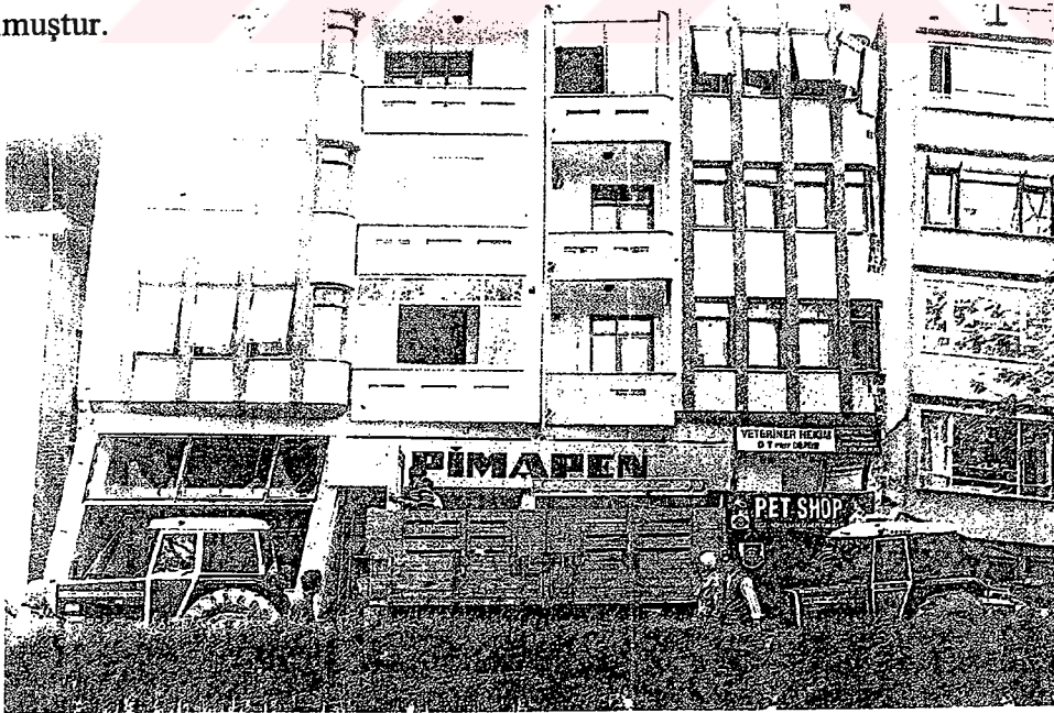
Şekil 3.2 Adapazarı'nda zemin katında yüksek dükkan boşluğu nedeniyle çok büyük miktarda öteleme yapmış bina (Bayındırlık ve İskan B., 2000).
