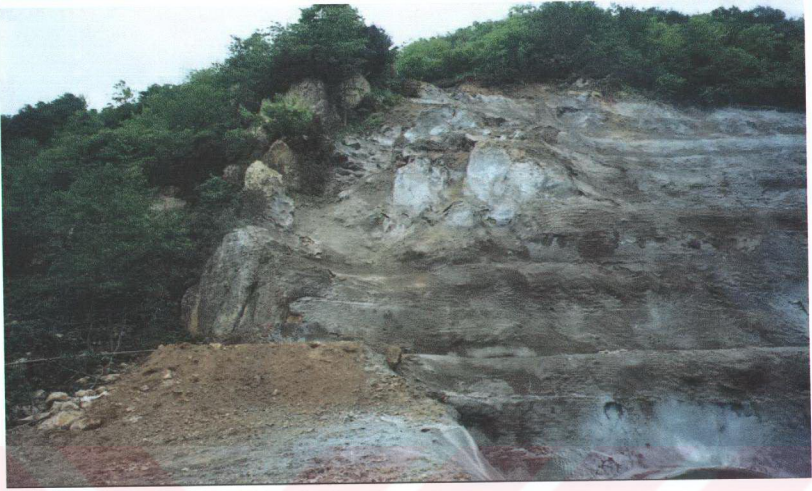
Fotoğraf 3.2 Uluburun Tünel girişi kazısı (Kaymanın hemen öncesi Kasım 1999 )
