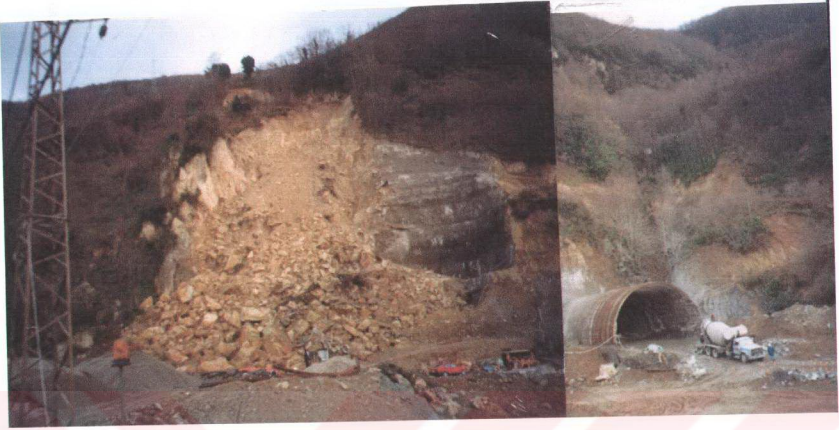
Fotoğraf 3.4 Uluburun Tüneli girişi kayma sonrası hattın güneye kaydırılmış durum (Şubat 2001)
