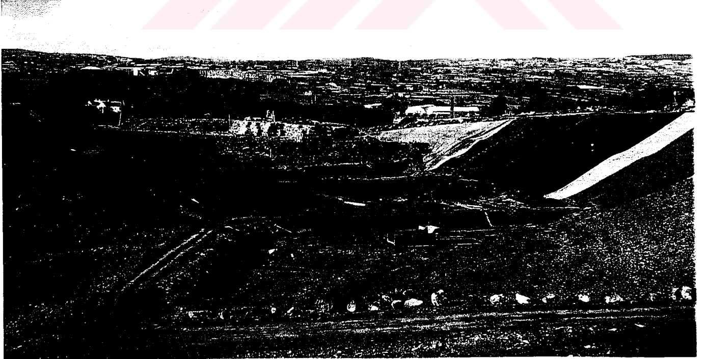
Şev korumasında geomembran uygulaması örneği
