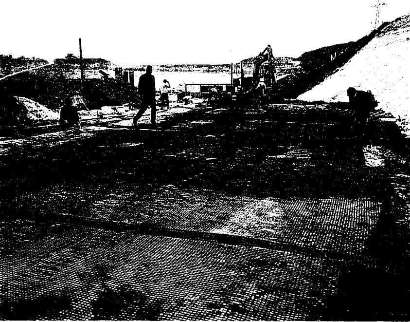
Şekil 2.16 Geogrid donatılı yol uygulaması
