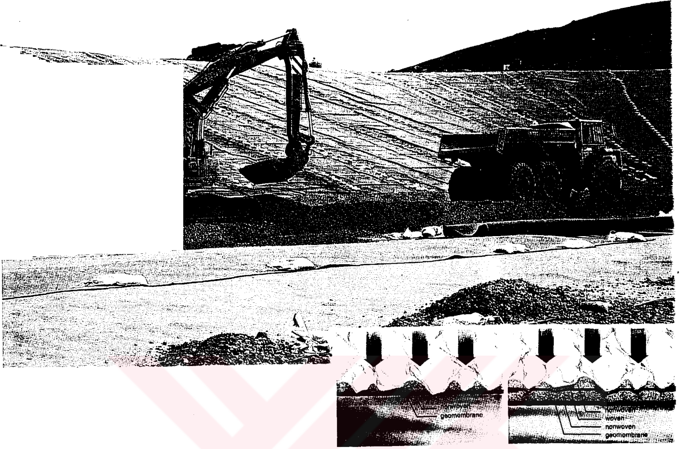
Geomembranların geotekstiller ile birlikte kullanıldığı uygulama örneği.
