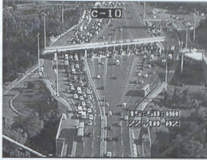
Şekil 6.16 22 Ekim 2002 tarihinde ek şerit açılmadan önce gişe sahasının durumu
