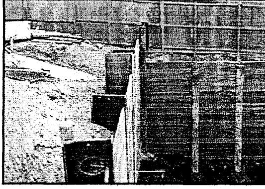
Şekil Ek 3.24 Ağır kerestelerle iksa oluşturulması
