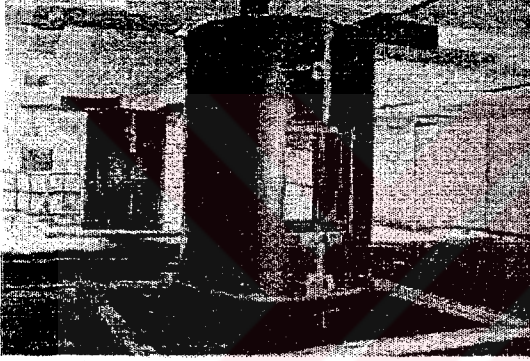
(3) Kolon ortasının kesilmesi
