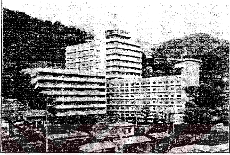
Şekil 6.6 Kat ortası izolasyonu yapılmış yapı
