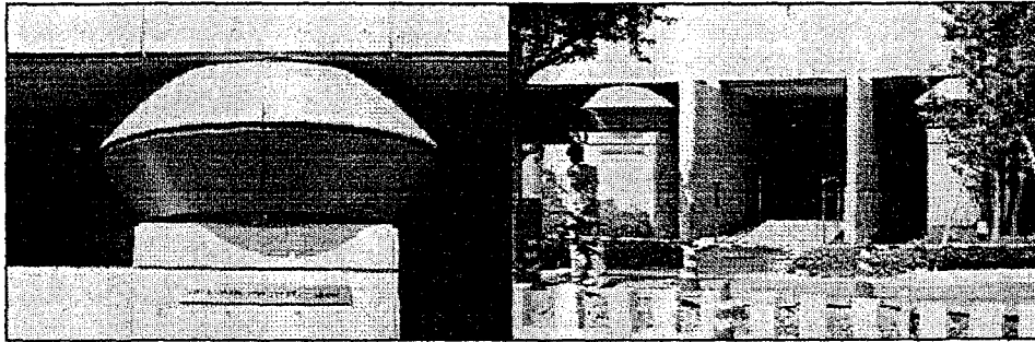
Şekil 5.8 Elastomerik izolatörlerde yangın önlemi**
