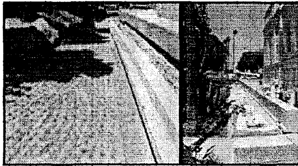
Şekil 3.34 Boşluk kapatıldıktan sonraki durum ve peyzaj çalışması
