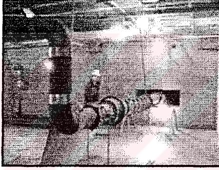
Şekil Ek 3.18 Duvarda açılan boşluk sayesinde hareket serbestliği kazanan kanalizasyon çıkışı
