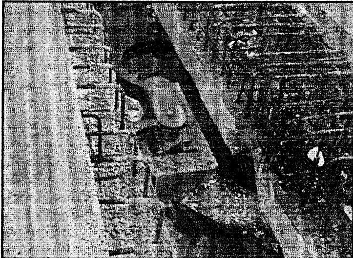
Şekil Ek 4.7 Histeretik sönümlendiricilerin depremden sonra durumu
