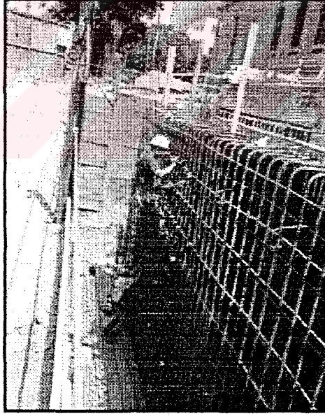
Şekil Ek 3.28 Donatıların çerçeve haline getirilmesi
