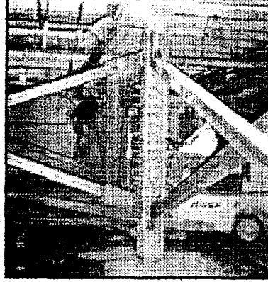
Şekil Ek 3.35 Kolonların beton yüzlerinin sökülmesi ve çapraz elemanlarla desteklenmesi
