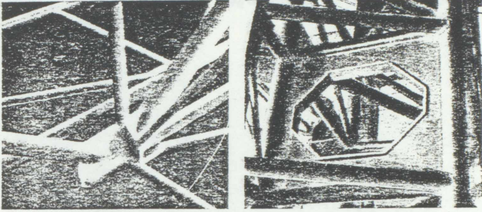
Resim 2.30 Uzaysal levhali düğüm noktası örnekleri. (3) (4)
