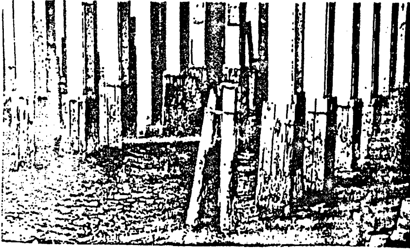
Şekil 2.4. Yeni önerilmeli beton kazıklara yerleştirilmiş kereste mantolamalar
