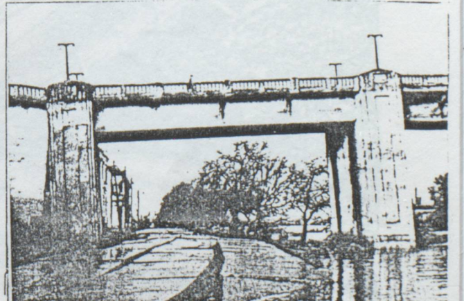
Şekil I.77 Zemin basıncından dolayı distorsiyon Isa-teja köprüsü Chile
