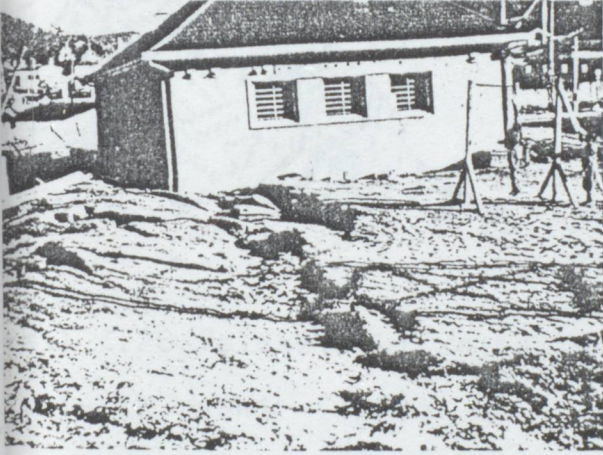
Şekil I.26 Sivilleşmiş kumlu arazide ev inşa edilmesi Puerto Montt (1960)
