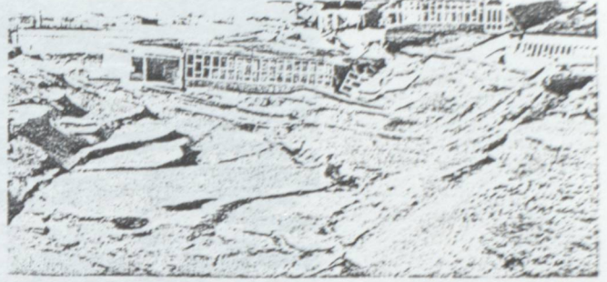
Şekil I.46 Government Hill okul bina- sında hasar Anchorage (1964)
