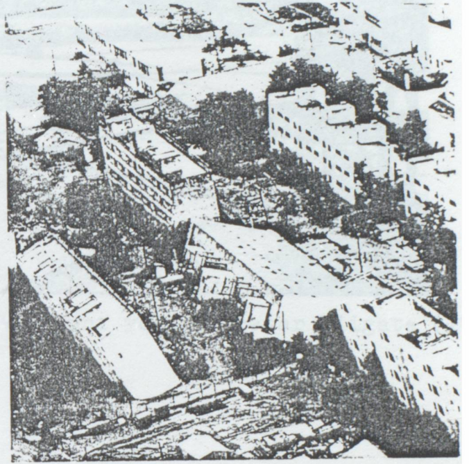
Şekil I.22 Eğilmiş apartımanlar Niigate (1964)
