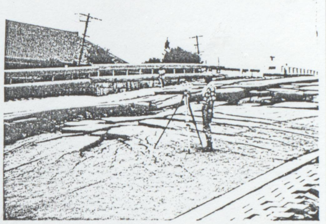
Şekil I.74 Kanat duvarları ve dolguda çatlak Niigate (1964)
