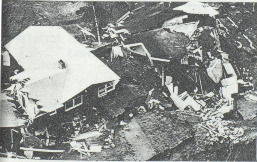
Şekil I.53 Turnagain Heigl alanında hasarlı evler Anchorage (1964)
