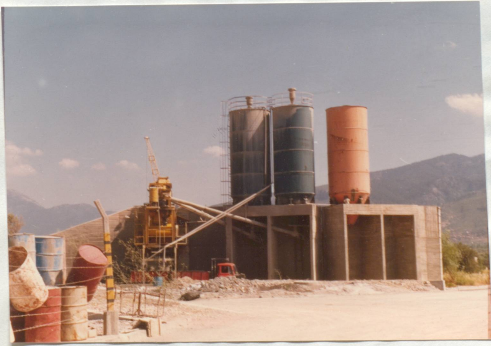
Şekil 28. Afaprefabrik tesisleri içindeki beton santralinden görünüş.
