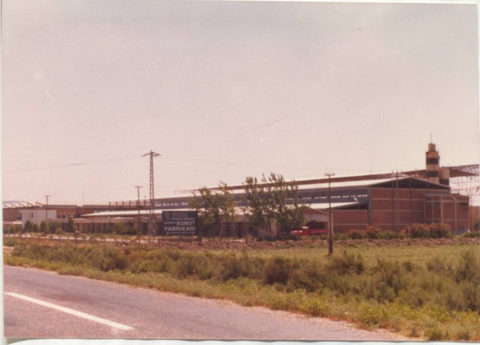
Şekil 59. Yübetaş tesislerinden genel görünüş.
