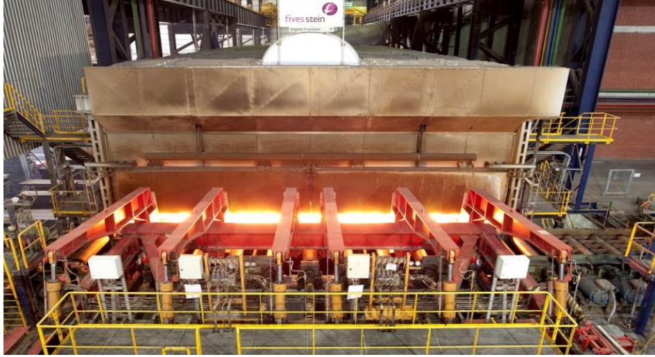
Şekil 3. 4 Tav fırını şarj ve deşarj makineleri
