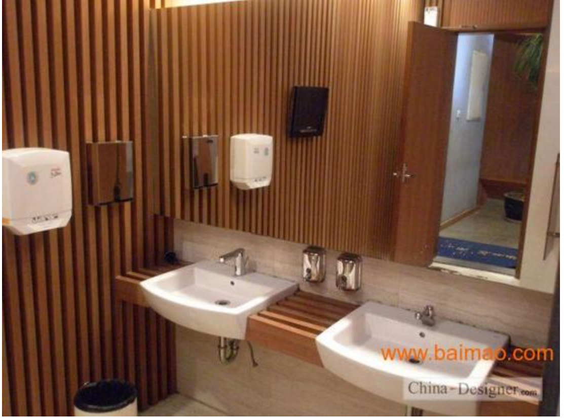
Şekil 2. 1 Ahşap-plastik kompozit malzemenin dış cephe ve banyoda kullanım örnekleri [6]
