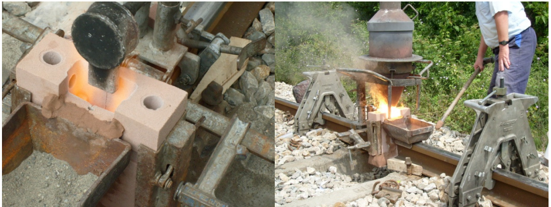
Şekil 4. 11 Ön ısıtma ve döküm işlemleri
