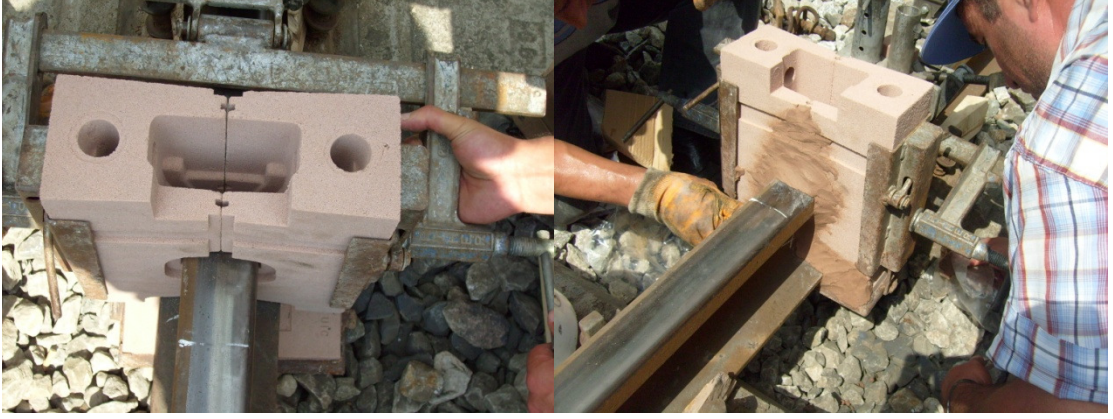
Şekil 4. 10 Kalıp bağlanması ve macunlama işlemi
