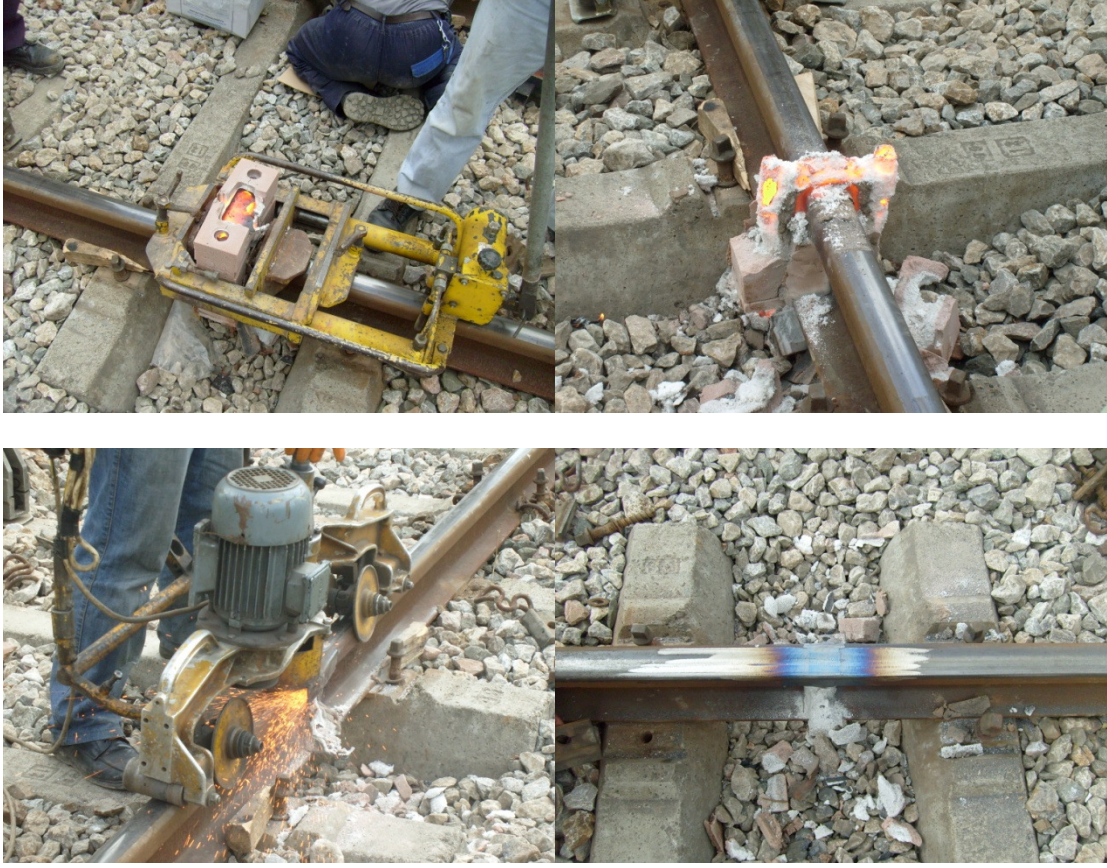
Şekil 4. 12 Kaynak fazlalıklarının sıyırılması ve taşlama işlemi
