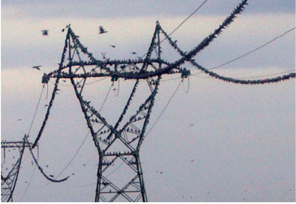
Şekil 2.5 Kuş işgaline maruz kalmış bir enerji nakil hattı (TEİAŞ, 2010)
