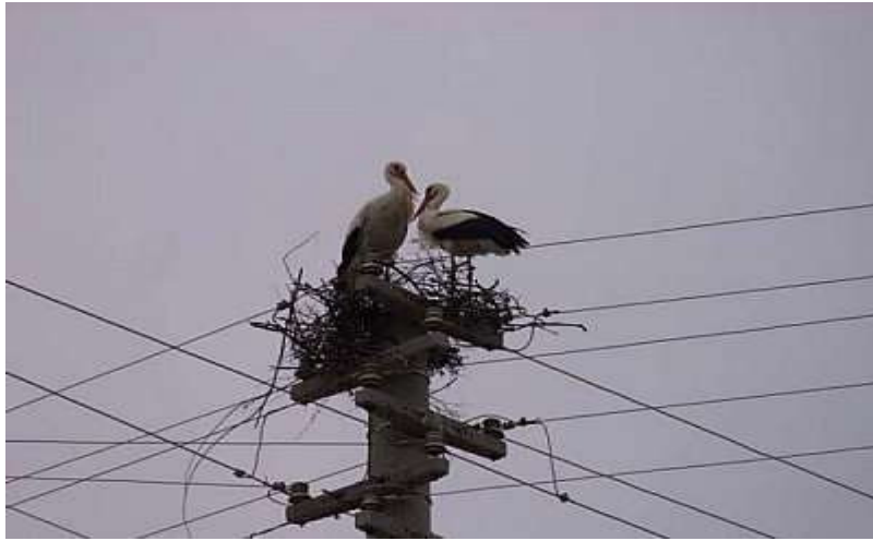
Şekil 2.6 Kuş yuvası haline gelmiş bir enerji nakil hattı direği
