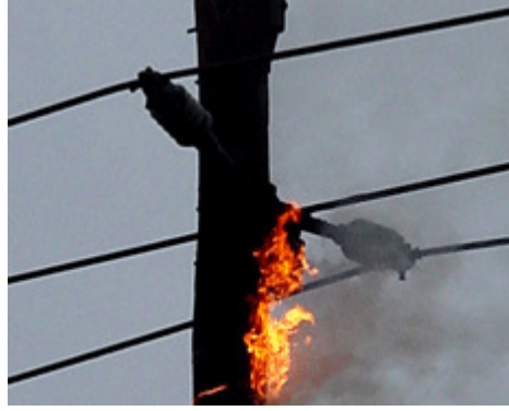
Şekil 2.7 Ark meydana gelmiş bir enerji nakil hattı direği
