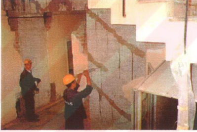
Şekil 7.17-İzo-BTS ve Epoksi Kaplama ile Tamir
