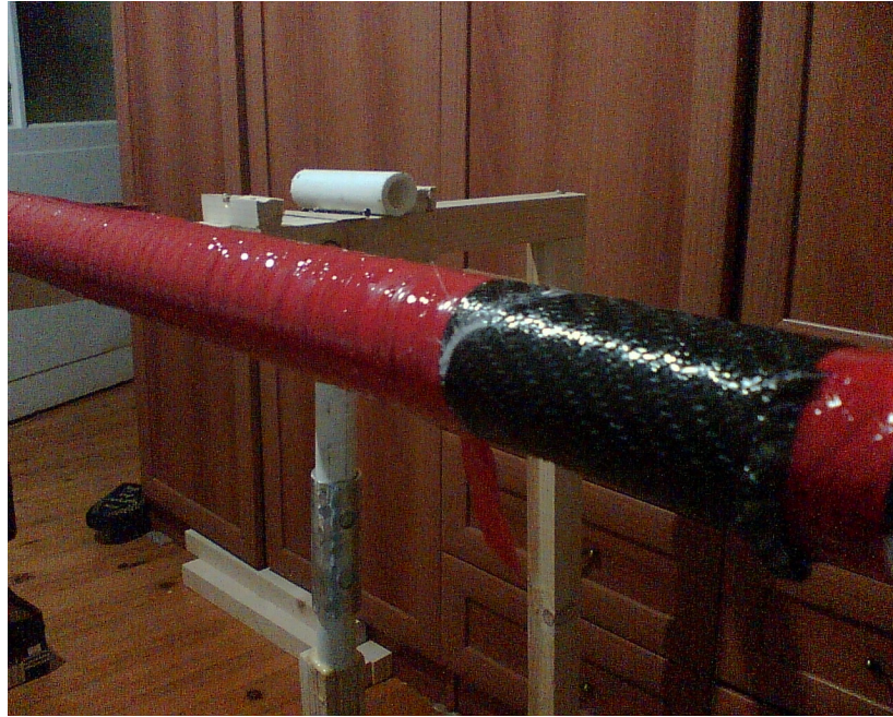
Şekil 4.14 İç katman borularının sarılması
