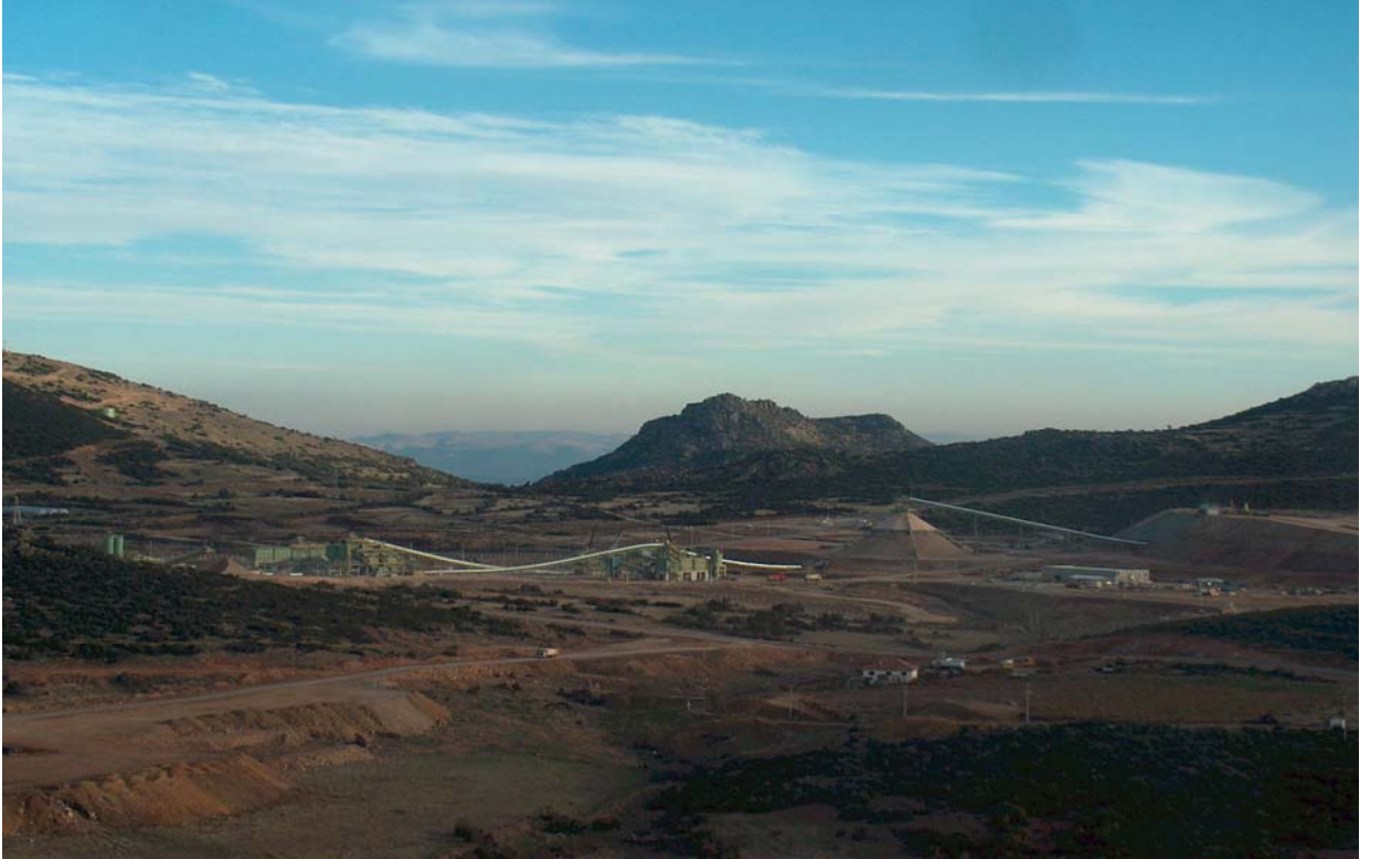
Şekil 8.14:Kışladağ-Eşme-Uşak Altın İşletmeleri Maden Alanı Cevher Hazırlama Tesisi
