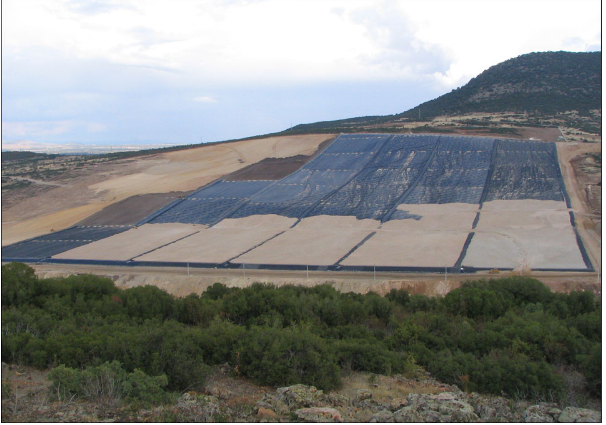
Şekil5.12:Kışladağ-Eşme-Uşak-Türkiye'de uygulanan yığın liçi işleminde liç alanı uzaktan görülmektedir.
