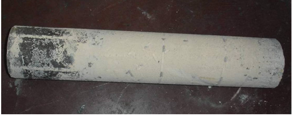
Şekil 3.5 Yetersiz kaplama uygulaması.
