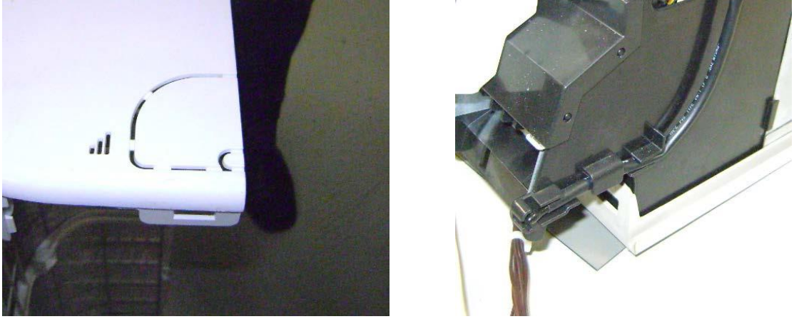
Şekil 2.9 İç ünite üzerindeki ortam sıcaklık sensörü yerleşimi
