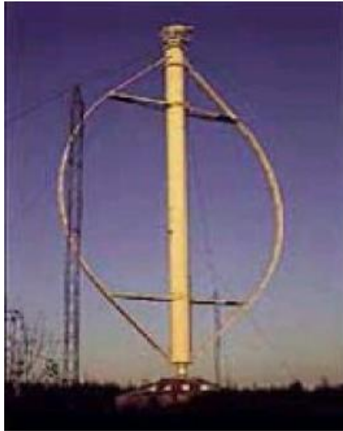
Şekil 2. 4 Darrieus tipi düşey eksenli rüzgâr türbini [11]
