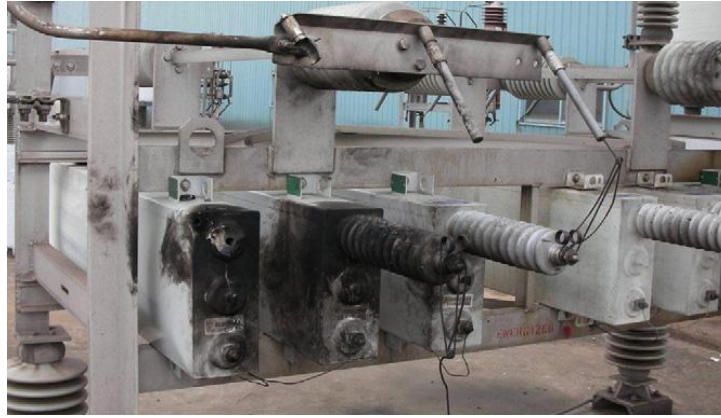
Şekil 5. 4 2. Harmonik filtrenin hasarlı kapasitör birimleri[10].
