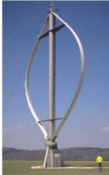
Şekil 3.2 Darrieus tipi düşey eksenli rüzgar türbini [19]
