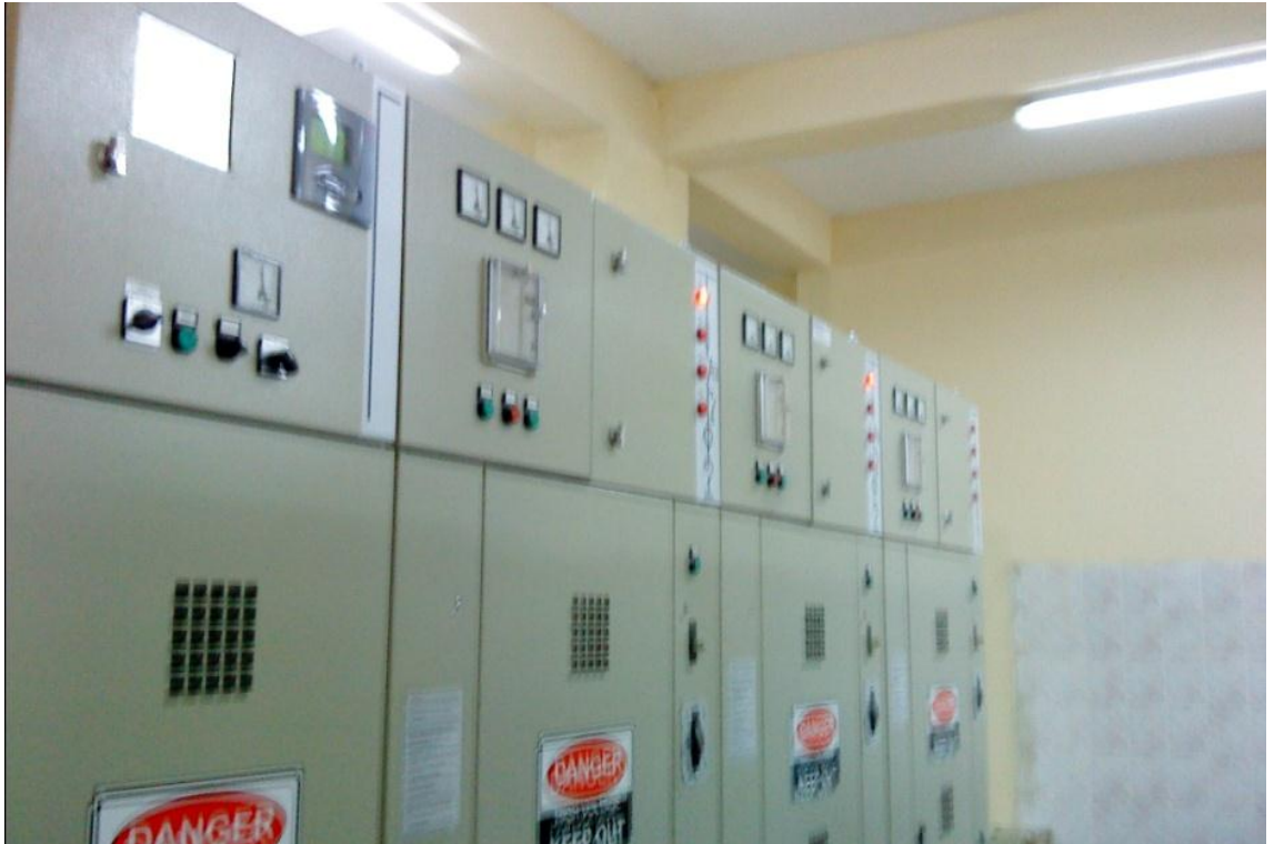
Şekil 4. 9 1250 kVAr' lık 3 adet metal mahfazalı kondansatör hücrelerinin görünümü
