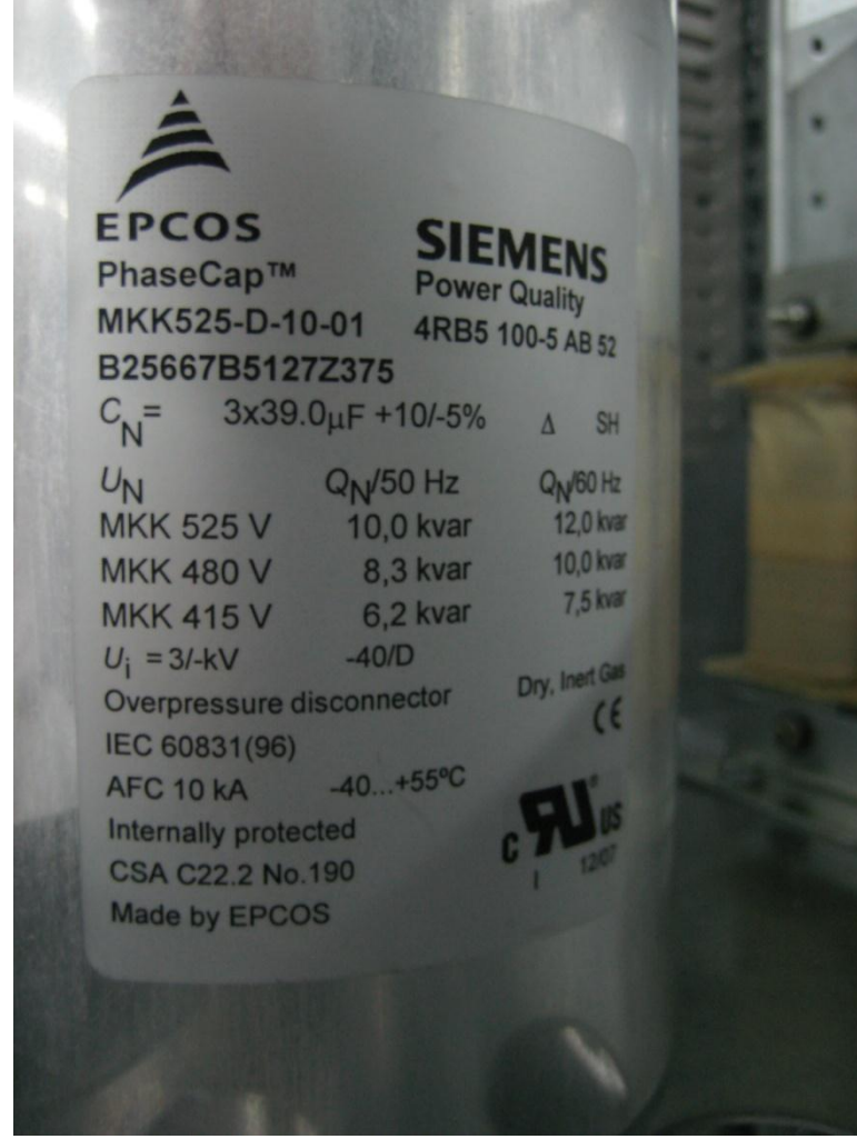
Şekil 3. 10 Kondansatörün dıştan görünümü
