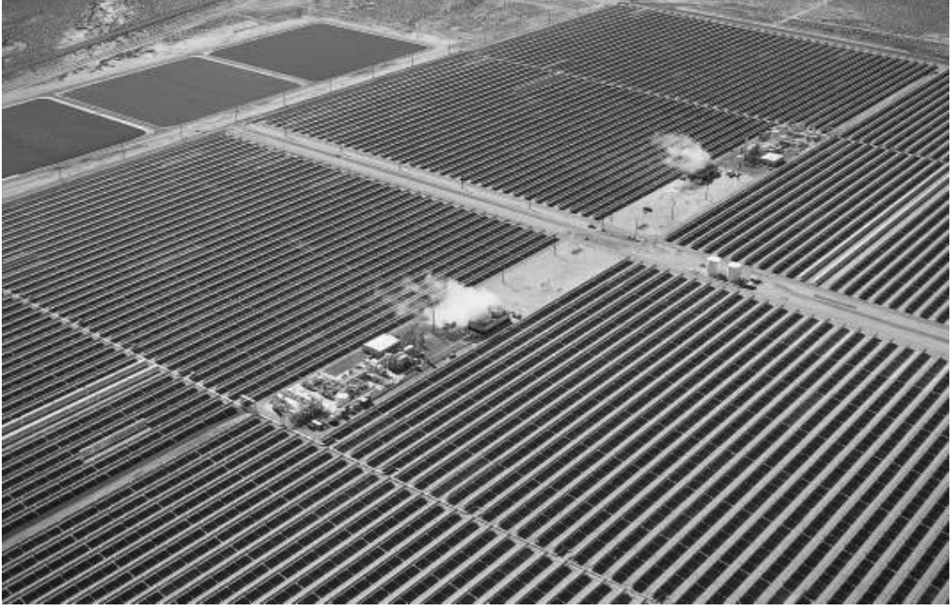
Şekil 3.3 AndaSol güneş enerjisi elektrik üretim tesisi [20]
