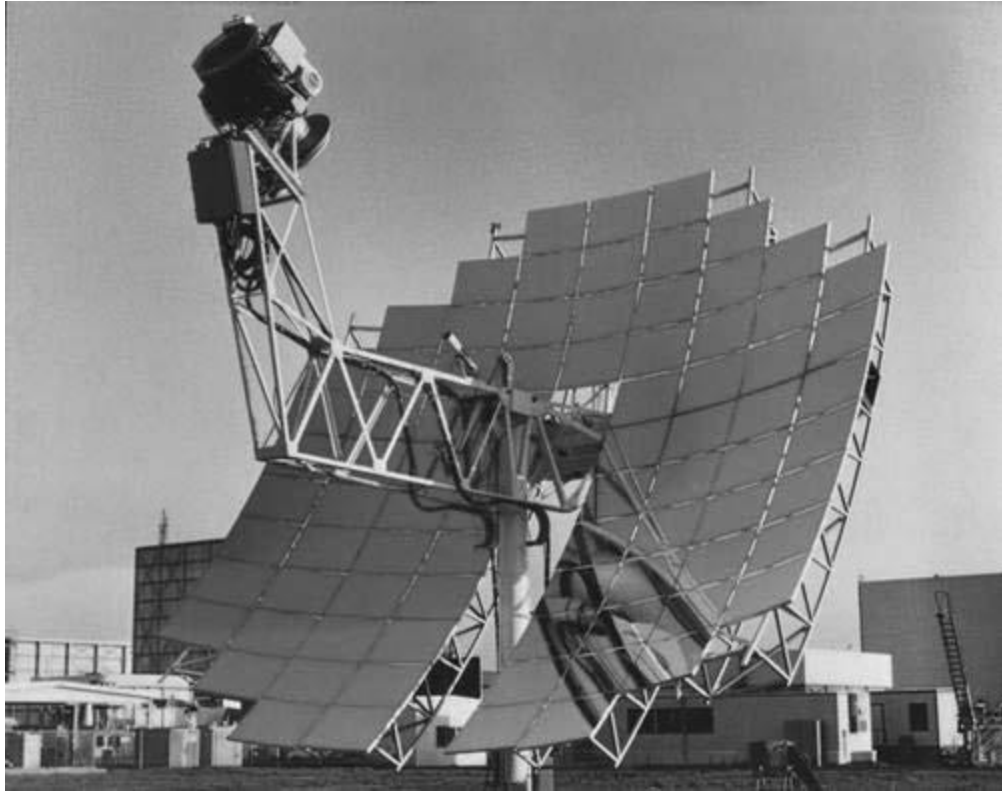
Şekil 3.5 Parabolik çanak sistemi [21]
