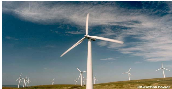
Şekil 2.17 Elektrik üreten üç kanatlı rüzgar türbinleri [17]
