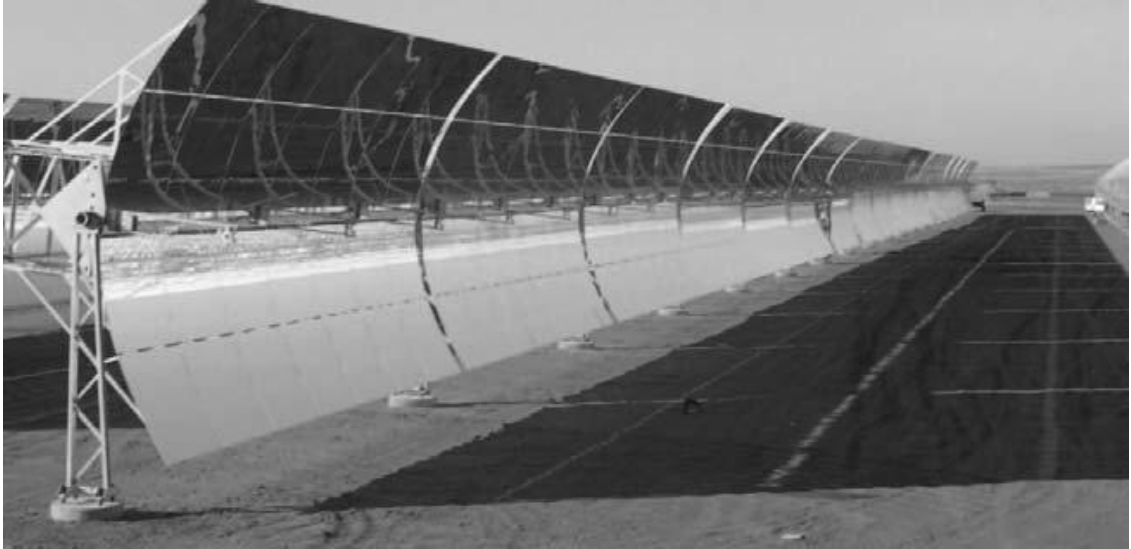
Şekil 3.2 Parabolik oluk yansıtıcı dizisi [20]
