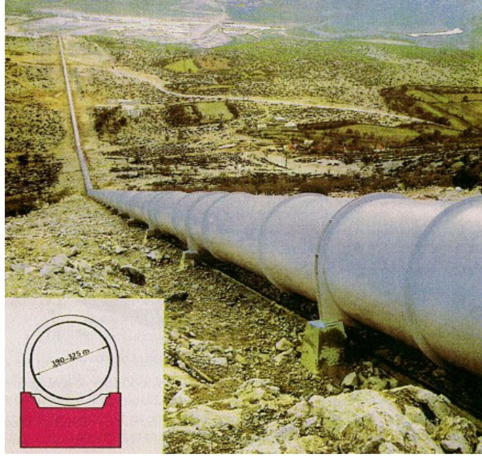
Şekil 2.2 Basınçlı boru hattı görünüşü [1]
