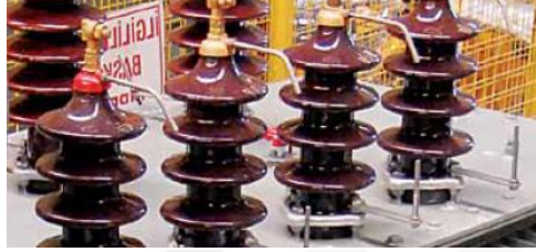
Şekil 2.19 Buşingler ve ark boynuzları[25]
