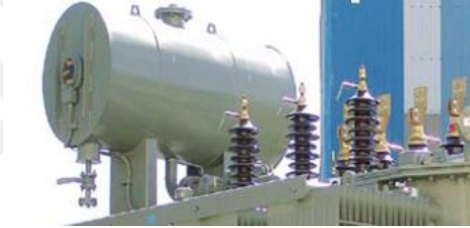
Şekil 2.12 Transformatör yağ genleşme deposu[23]
