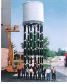
Şekil 4.15 Hava çekirdekli yapı Enduktans: 150 mH Gerilim: 500 kV DC Akım: 1800 A DC
