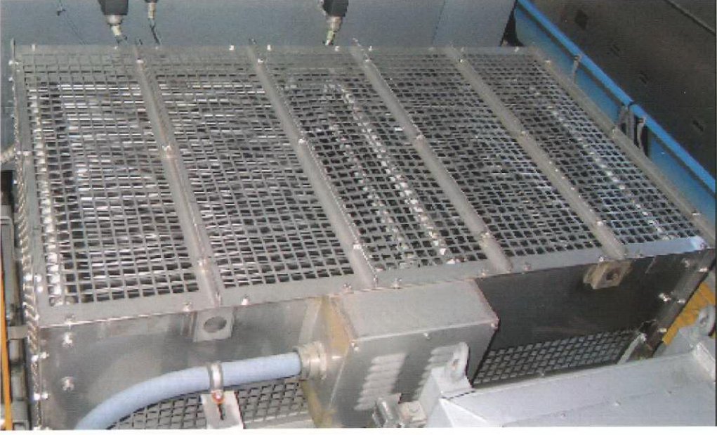
Şekil 5.16 Fren rezistörünün mekanik dizaynı
