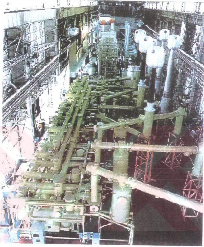
Şekil 12.5 550 kV'luk G.I.S. tesisinin fabrika montajı
