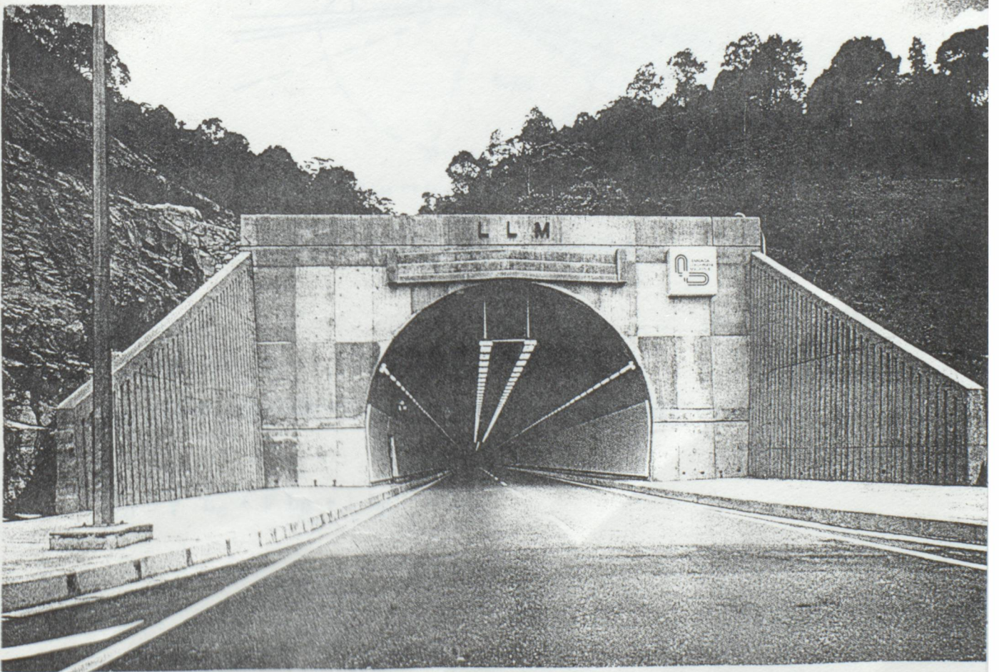
Şekil 9.9. Malezya'da IPOH tünelinin giriş bölgesinin görünüşü.
